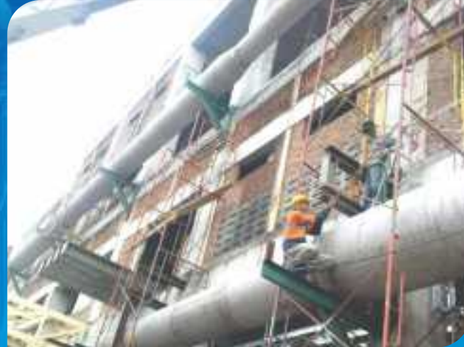
PIPE SUS ERECTION
